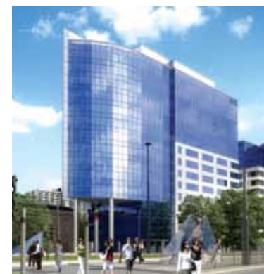
Atrium 1 w Warszawie
